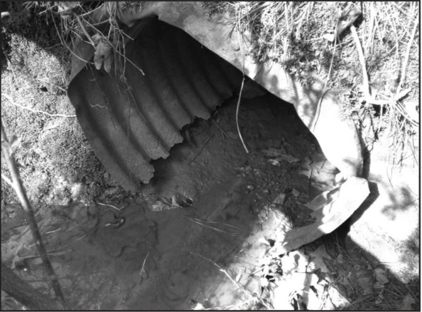
**Problem:** corroded metal pipe.
